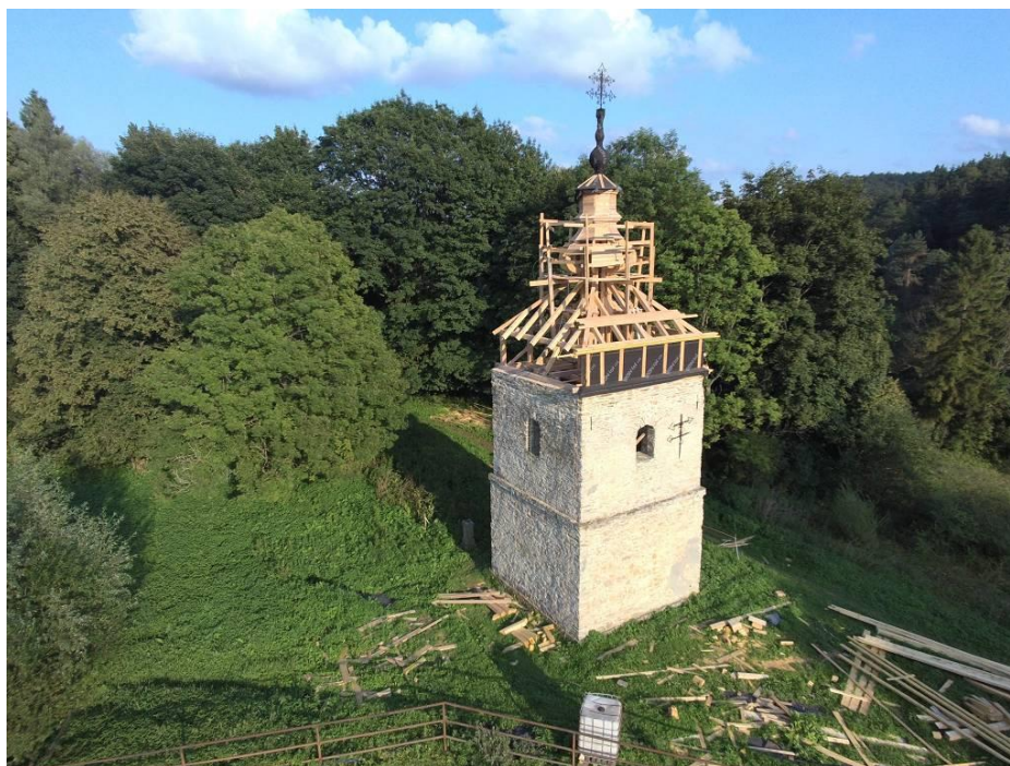
Odbudowa dzwonnicy w Polanach Surowicznych – stan z 17.08.2018 (fot. Witold Grzesik)
