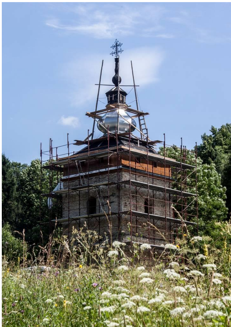
Stan remontu dzwonnicy z 5 lipca 2019 roku (fot. W.Grzesik)
